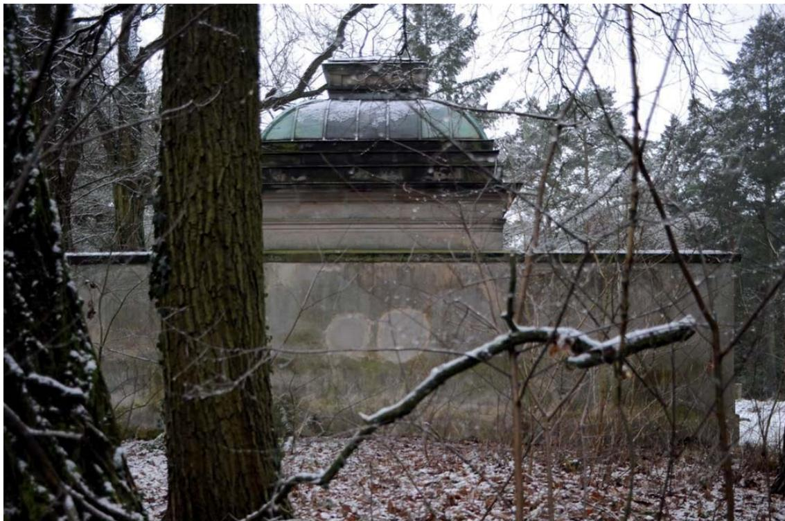
Abb. 20: Rückansicht mit Verfärbungen und partieller Ausbesserung am Putz
