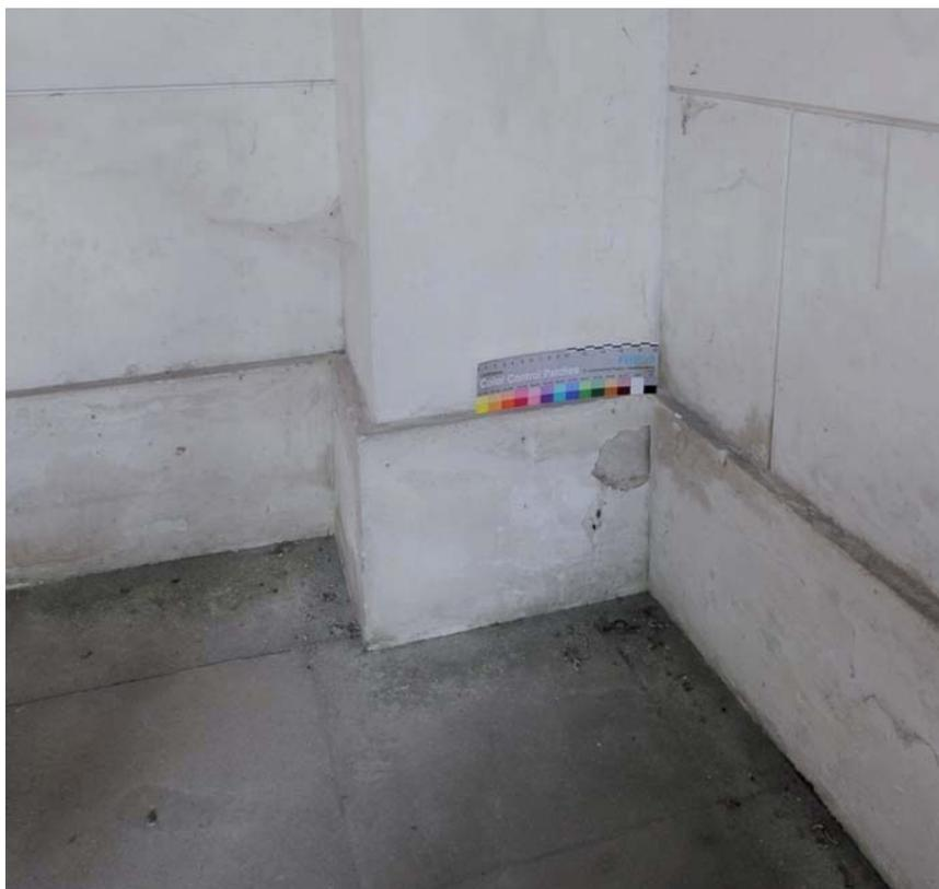
Abb. 32: Detail Sockelzone rechte Seitenwand: Oberflächenverlust durch Schalenverlust
