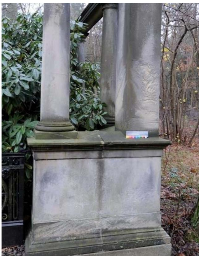
Abb. 21: Detail Säulenbau rechts: Texturabhängige Auswitterung von Gesteinskomponenten, dunkle Verfärbung bis Kruste an Abdeckung, Säulen und Pfeiler
