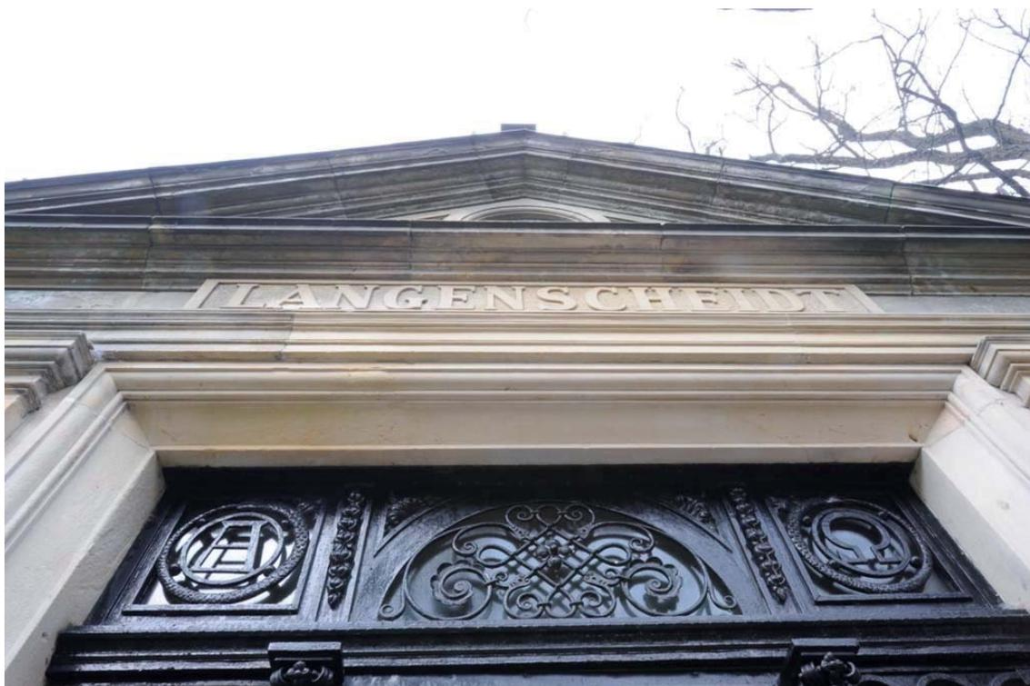
Abb. 22: Detail Ansicht: Dunkle Verfärbung bis Kruste an Giebeluntersicht
