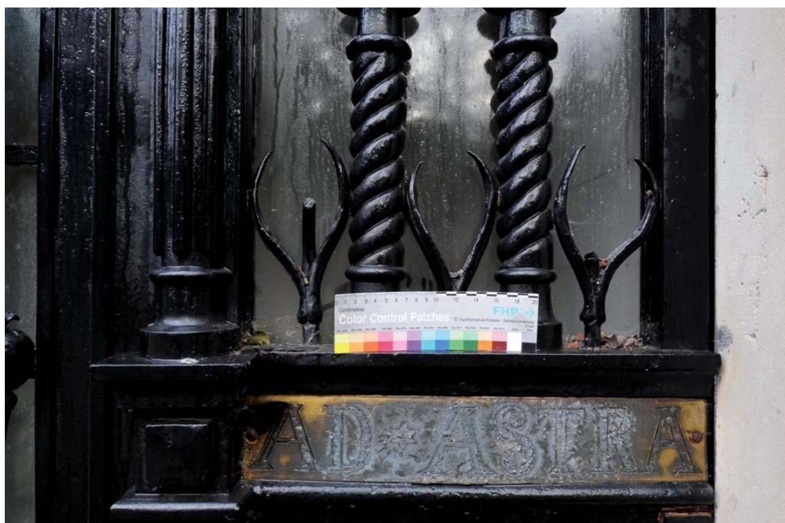
Abb. 25: Detail Tür; rechte Seite: Verfärbung und Oberflächenveränderung der Schriftplatte, sowie fehlende Zierblumen durch anthropogenen Einfluss
