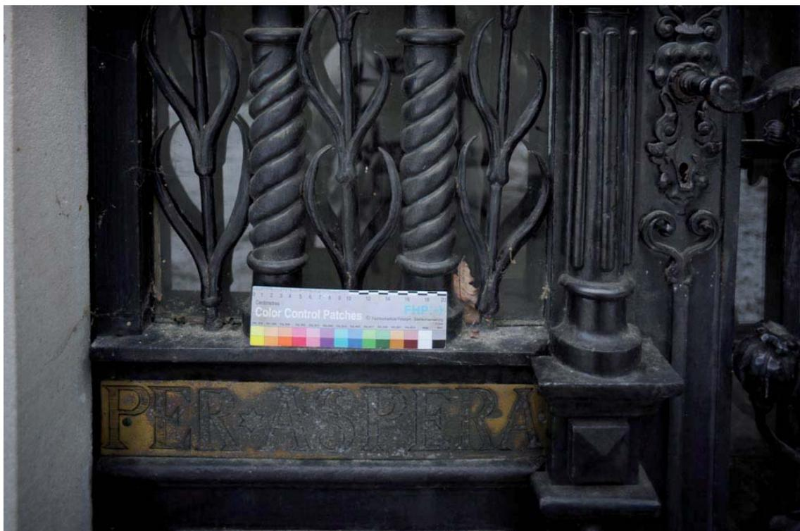
Abb. 24: Detail Tür; linke Seite: Verfärbung und Oberflächenveränderung der Schriftplatte
