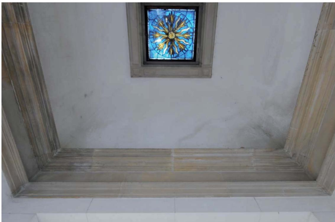
Abb. 31: Detail Decke: Feuchtflecken im Gewölbe
