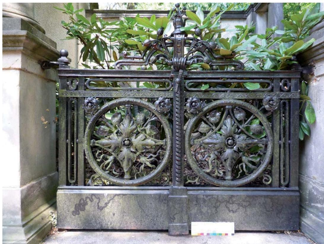
Abb. 27: Detail rechter Anbau: schmiedeeisernes Tor, identisch mit dem Tor des linken Anbaus
