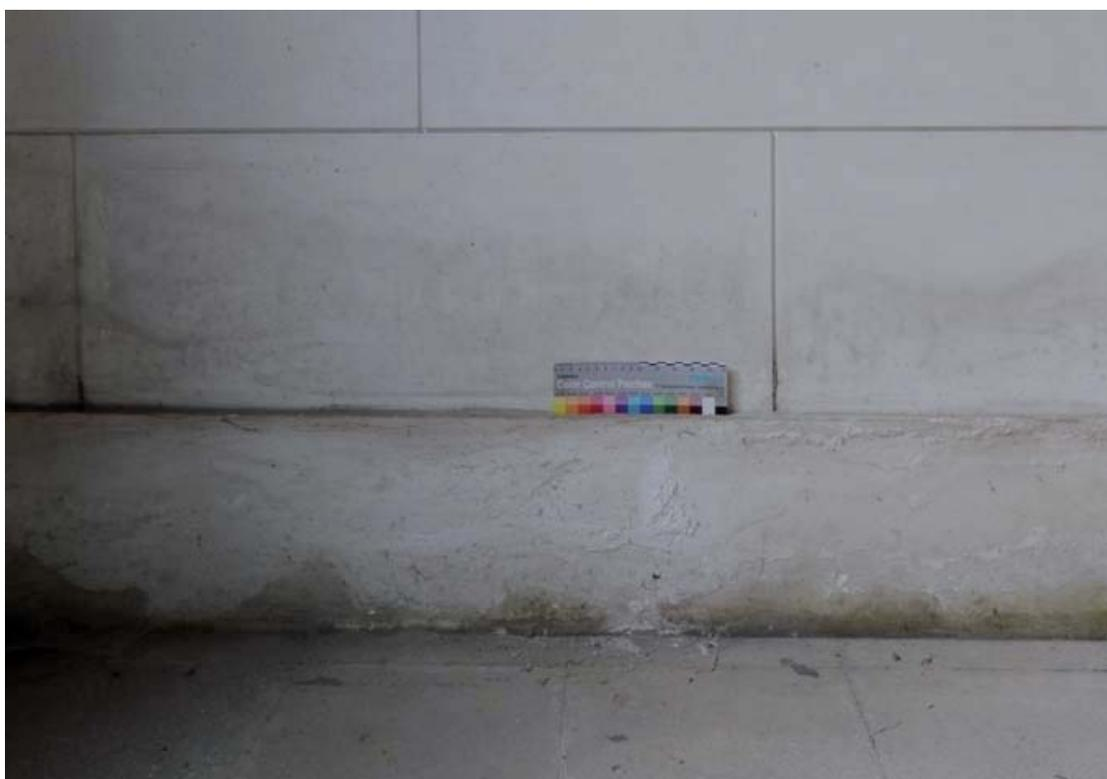
Abb. 33: Detail Innen: Salzausblühungen an der Sockelzone, sowie sichtbarer Feuchtehorizont
