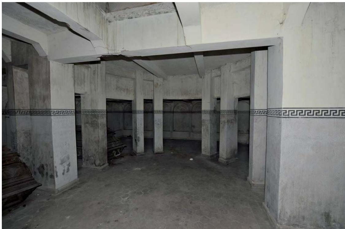
Abb. 42: Ansicht mit Pfeilerstellung dem Grundriss des Oberbaus entsprechend und Seitenwand rechts
